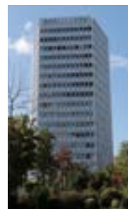
Bâtiment de l'UIT
